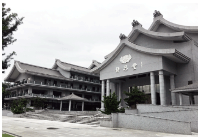
マレーシア・ツーチー基金会スランゴール・KL支部、静思堂。2010年に着工し、14年に完成。総工費は8,000万リンギ（約22億4,700万円）と言われる。（筆者撮影）
